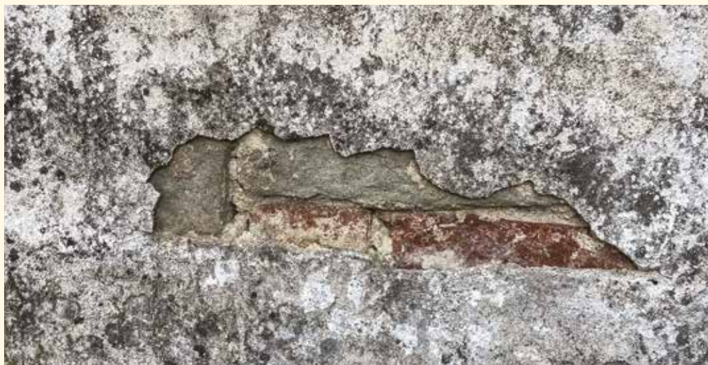
Particolare del tessuto murario in una zona priva di intonaco. Si nota un'alternanza di pietre e mattoni
