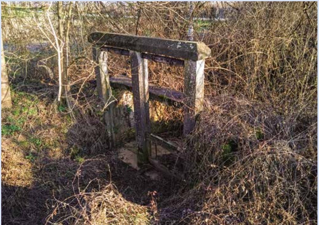
Fig. 4b - Chieri, Strada vecchia di Buttigliera, impianto a "balconera" sul Rio della Sabbia.
